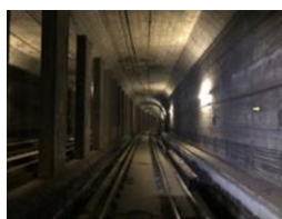
写真-1 覆工内部
