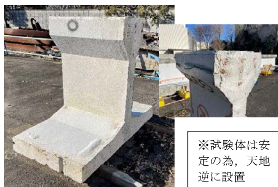
写真-1 試験体とひび割れ発生状況
