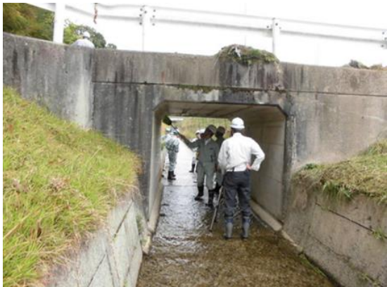
写真 - 2 対象とした橋梁の外観
