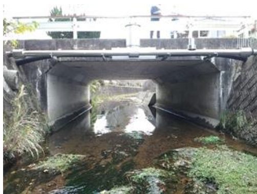
写真 - 2 対象とした橋梁
