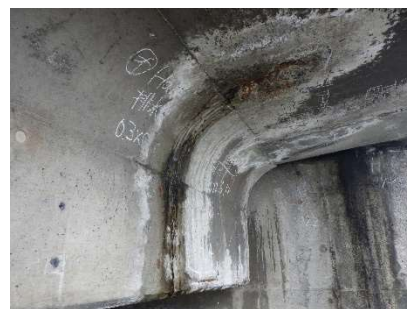
図-3 現地計測を行った橋梁
