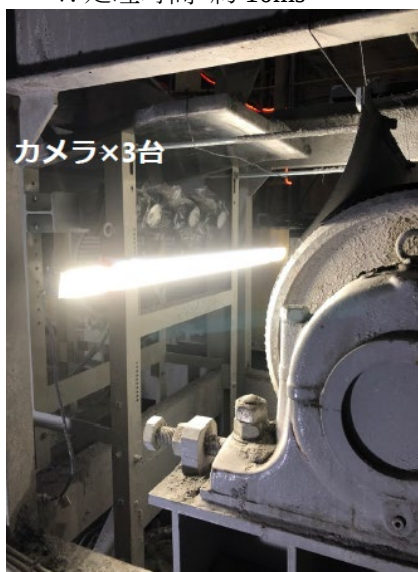
写真 1. カメラ設置状況
