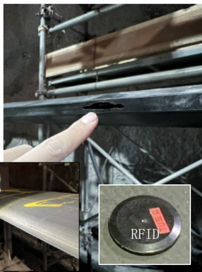
写真 2. RFID 設置状況
