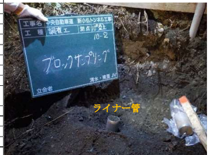
写真-2 ブロックサンプリング状況
