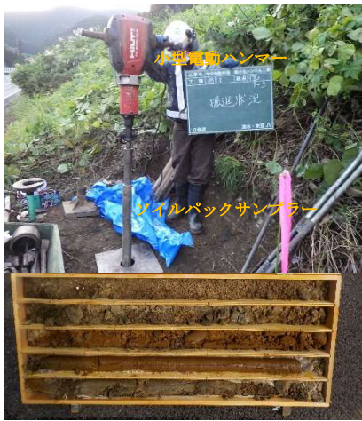
写真-1 SCSC ボーリング・コア採取状況
