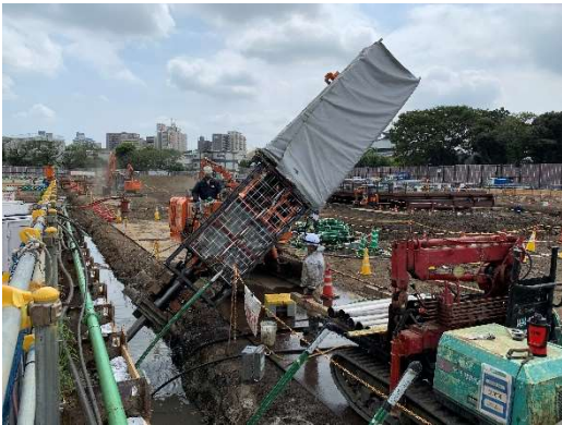
写真 1 グラウンドアンカー施工状況
