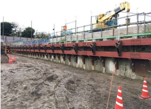
写真 2 グラウンドアンカー施工完了
