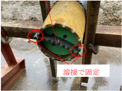
写真-3 ケーシング先端状況
