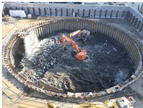
図-7 地下部解体状況
