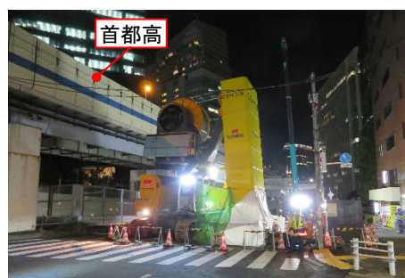
写真1 CSM 工法 機械配置状況
