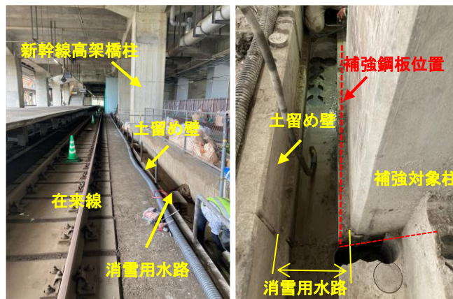
写真-1 現場状況
