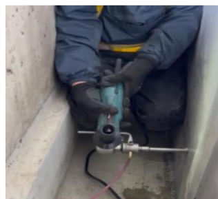
写真-5 削孔状況
