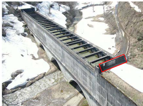
図-1 当該水路橋（全景、赤枠部にてコアを採取）
