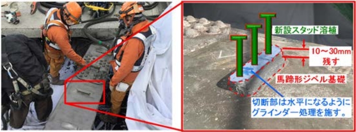
図-1 馬蹄形ジベル基礎上面へのスタッド溶植の概要
