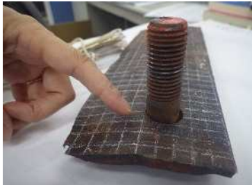
写真-5 面外変形した添接板
