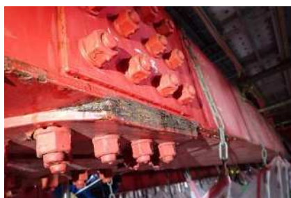
写真-1 下弦材下フランジ
