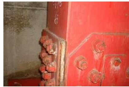
写真-3 端対傾構垂直材
