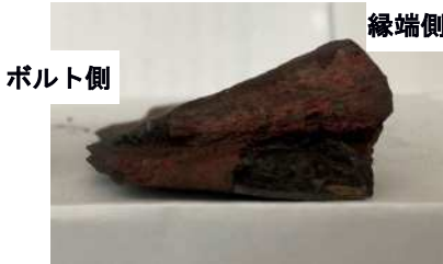
写真-4 撤去した錆
