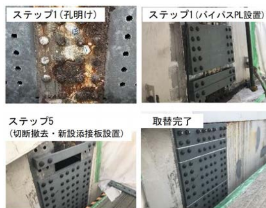
写真-2 添接板取替え状況
