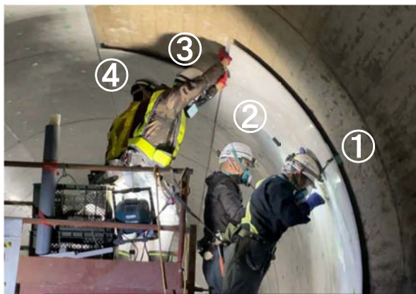
写真-1 レジコンパネル設置状況
