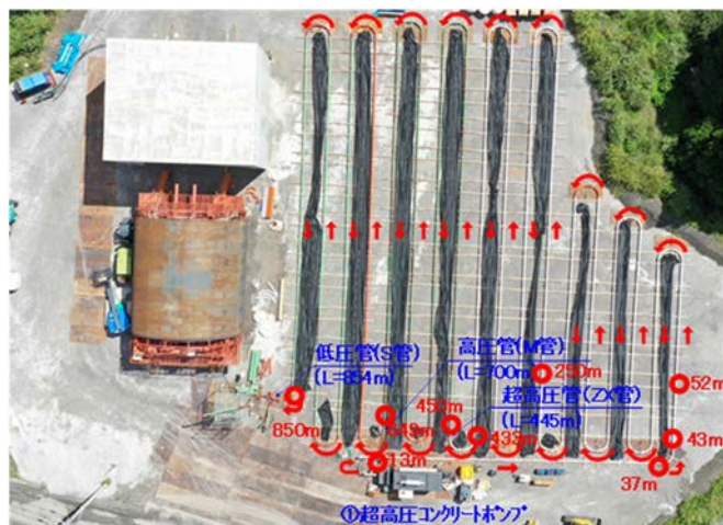
写真-1 長距離圧送・充填試験状況
