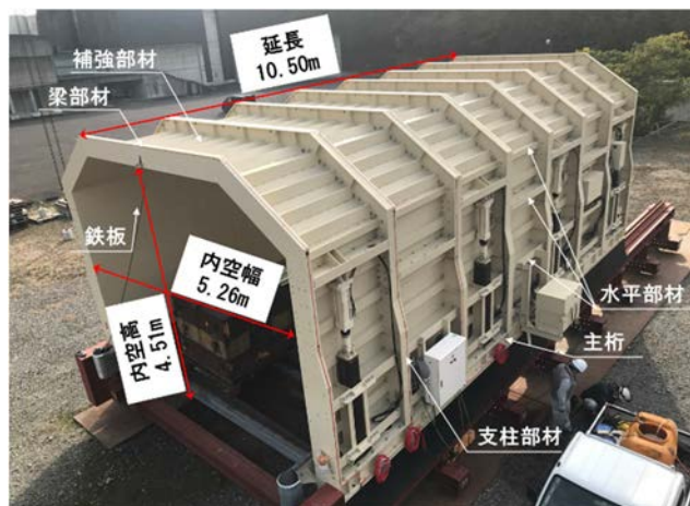
図-1 防護工全景
