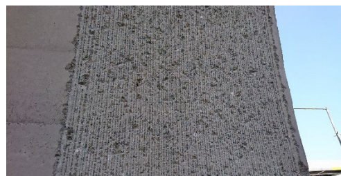
写真-3 側壁部切削仕上がり面
