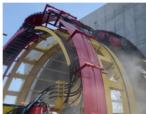
写真-2 既設覆工切削状況
