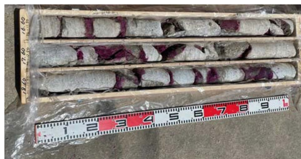
写真-2 チェックボーリングコアによる充填確認
