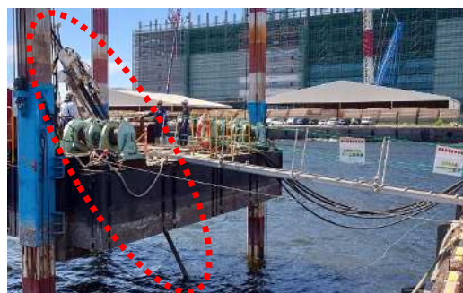
写真-1 夾雑物除去の作業状況(削孔)
