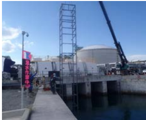
写真-8 海中足場設置状況
