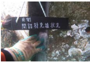
写真-10 間詰材充填作業状況
