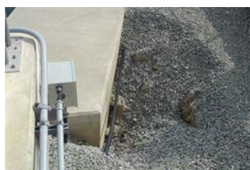
写真-2 令和3年度陥没状況
