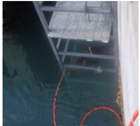
写真-9 海中足場内作業状況
