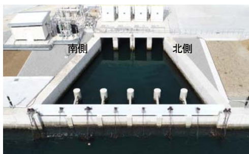
写真-1 取水口全体
