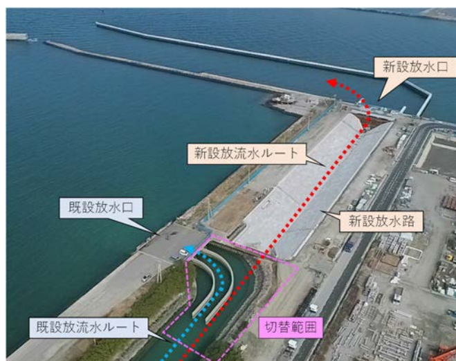
写真-1 放水路鳥瞰図(切替施工前)
