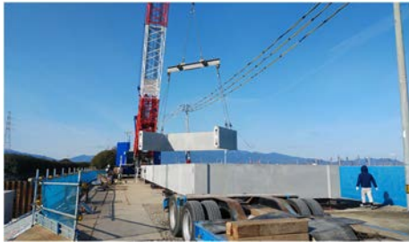
写真-3 セルラブロック搬入
