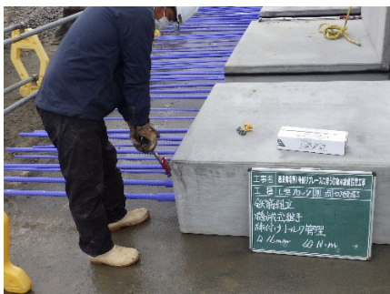
写真-6 機械式継手組立
