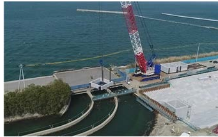
写真-4 セルラブロック据え付け
