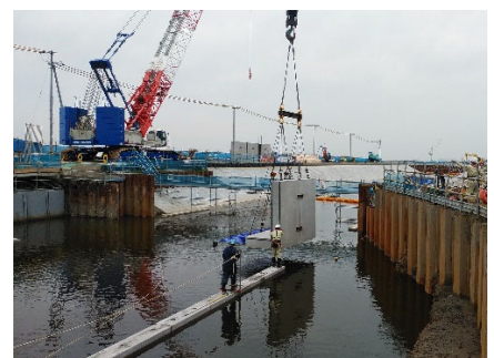
写真-8 L 型ブロック据え付け
