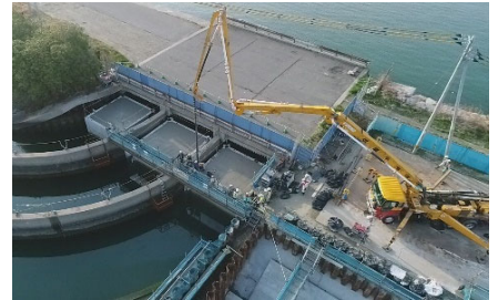
写真-5 間詰めコンクリート打設
