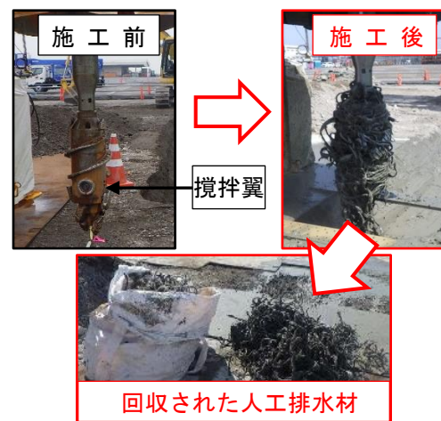
図－２ 施工に伴う人工排水材の排出状況
