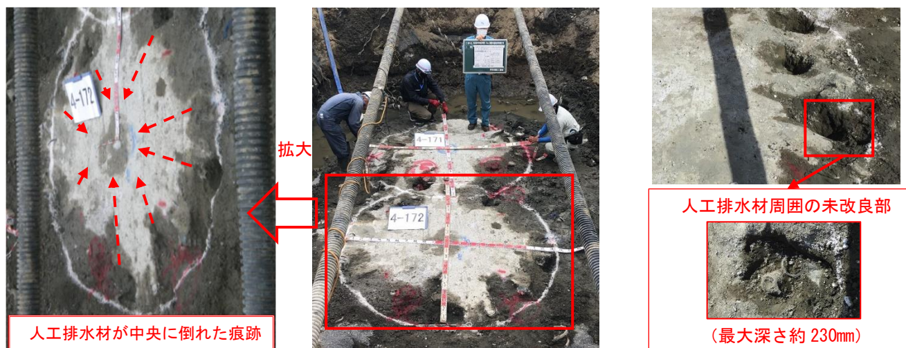
図－３ 固化改良体天端確認状況
