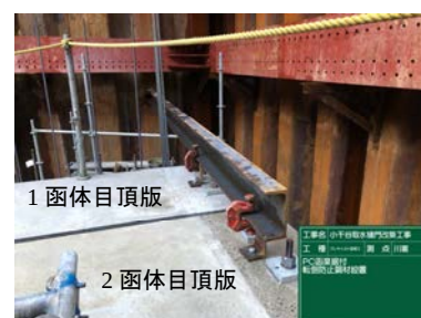
写真-4 転倒防止鋼材（頂版上面）
