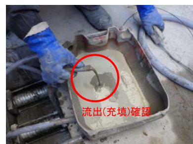
写真-8 PC グラウト充填確認
