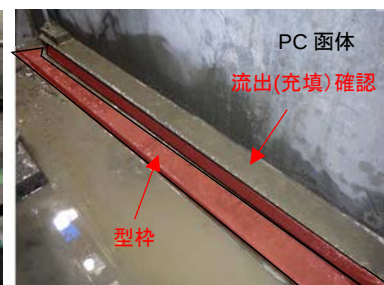
写真-6 裏込め材充填確認
