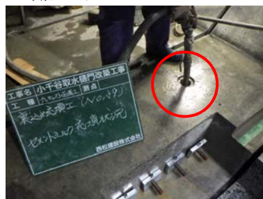
写真-5 裏込め材充填
