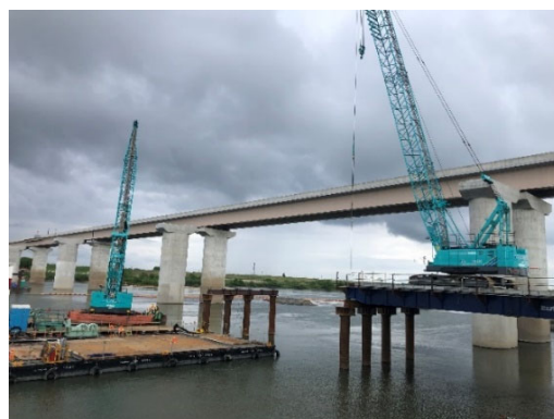
写真4 仮設栈橋施工状況
