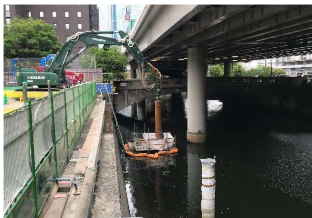
写真-2 リーダーレス杭打ち機による鋼管杭打設状況
