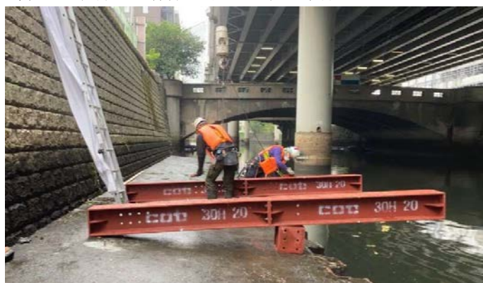
写真-4 定規材設置状況
