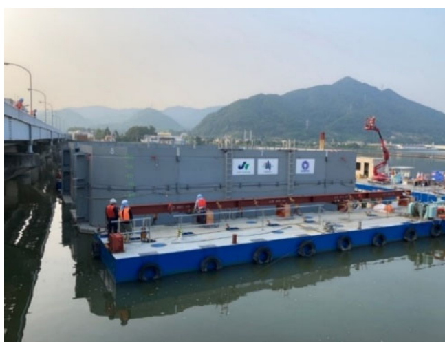
写真-3 仮締切据付状況
