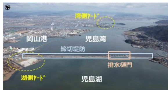
写真-1 締切堤防排水樋門位置
