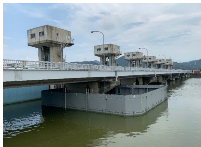
写真-3 仮締切据付状況
