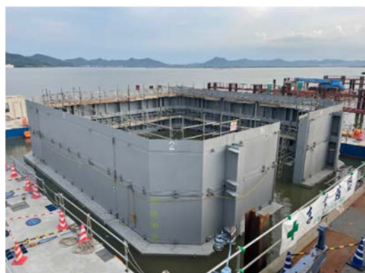
写真-2 仮締切水上組立・設置状況
