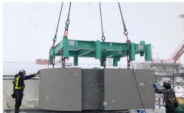
写真-5 プレキャスト部材吊り治具
