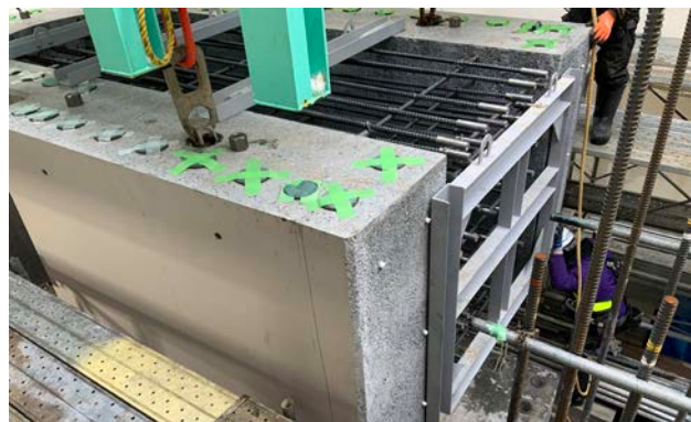
写真-4 プレキャスト部材補強材
