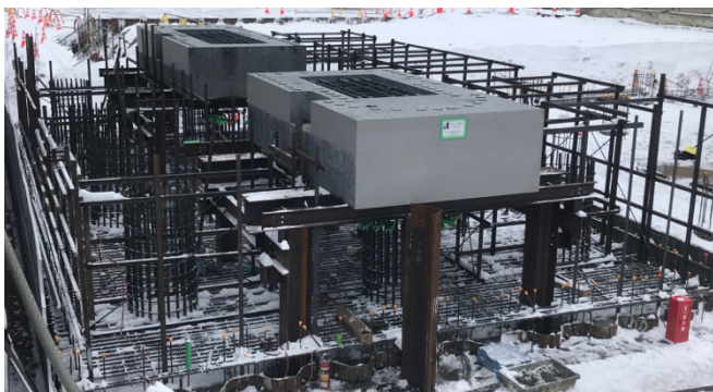
写真-2 埋設プレキャスト設置状況
