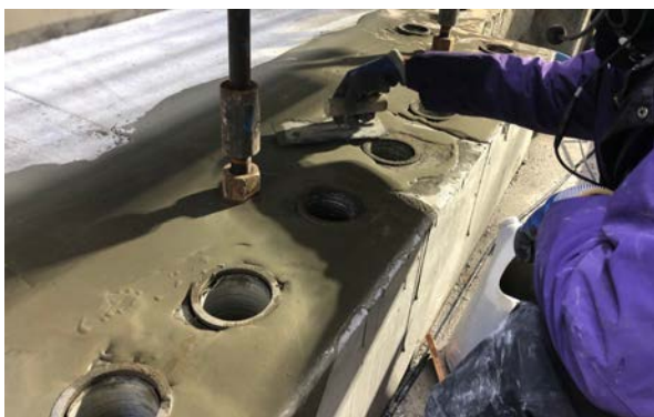
写真-3 充填剤塗布状況
