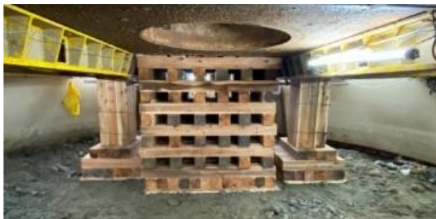
写真－4 傾き抑制木製サドルの設置状況
