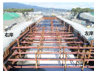
写真2 床付状況（ドライワーク）
