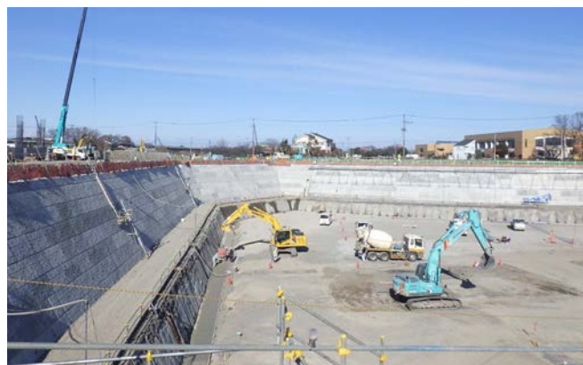
写真-3 調整池擁壁構築状況
