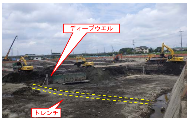
写真-2 調整池掘削状況
