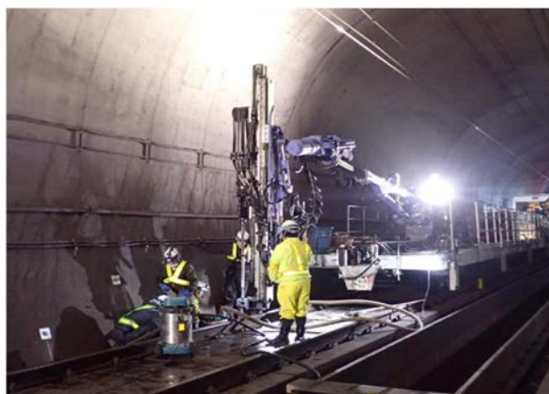
写真-2 ロックボルト削孔
