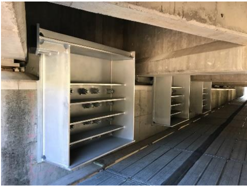
図-1 耐震補強部材設置例
