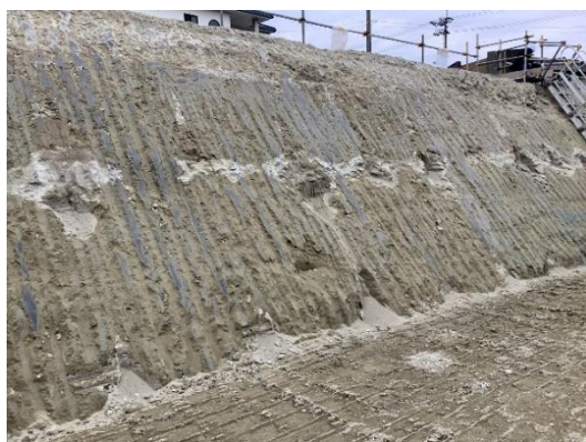
写真-1 地盤改良体方式鉛直土留め壁
