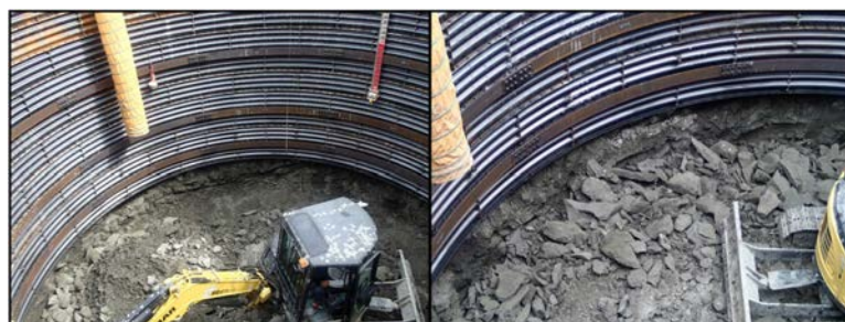
写真-2 内部掘削状況
