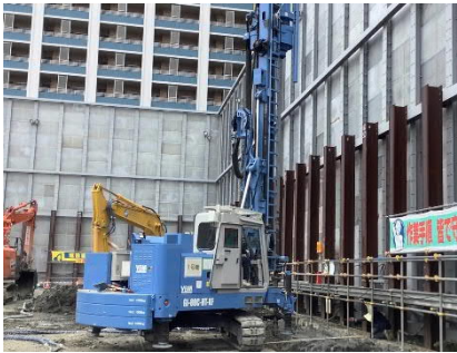
写真-1 施工状況
