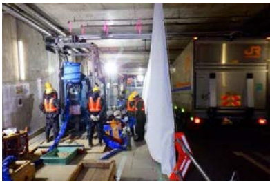
図-5 試験施工状況
