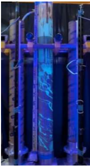
写真-4 引上げ状況
