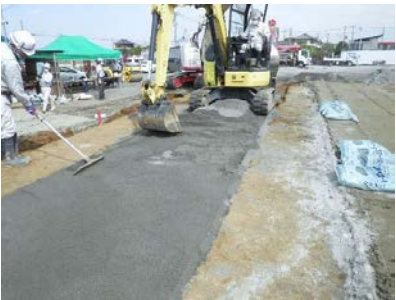
写真-1 固化材敷均し状況
