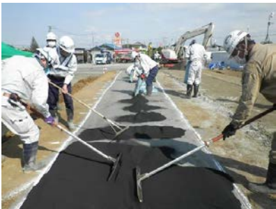
写真-2 バイオ炭敷均し状況
