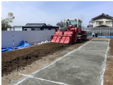
写真-3 混合攪拌状況
