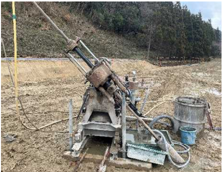
写真-1 斜め45°ボーリング状況
