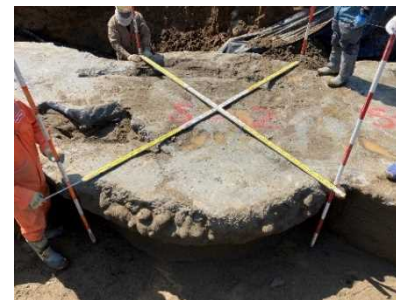
写真-6 改良体上部 (砂地盤 5分/m)
