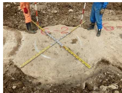
写真-4 改良体上部 (原地盤 5分/m)
