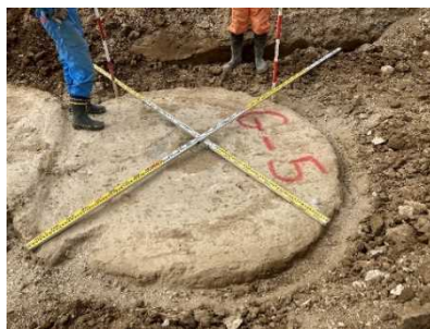
写真-3 改良体上部 (原地盤 4分/m)
