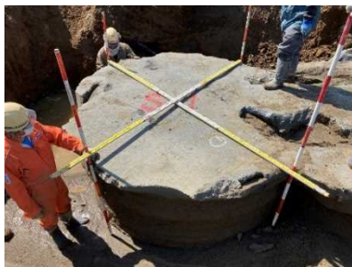
写真-5 改良体上部 (砂地盤 4分/m)
