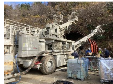
写真-2 吹付け機
