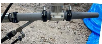
写真-5 Y字管添加システム
