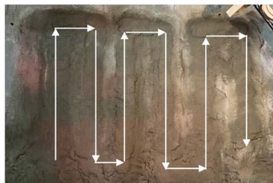
写真-1 吹き付け状況
