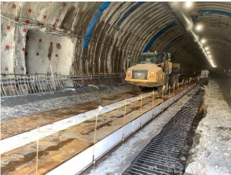
写真-2 EPS-B・鉄板の敷設状況
