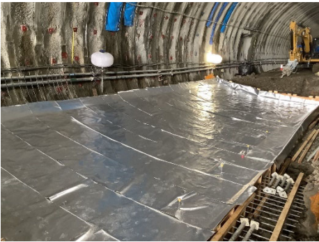
写真-1 養生マット敷設状況
