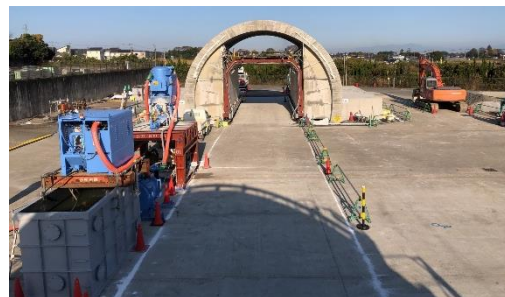
図-4 模擬トンネル全景
