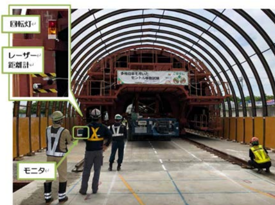
図-3 トンネル移動試験状況
