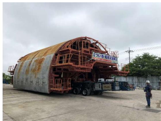
図-1 多軸台車，運搬架台，セントル
