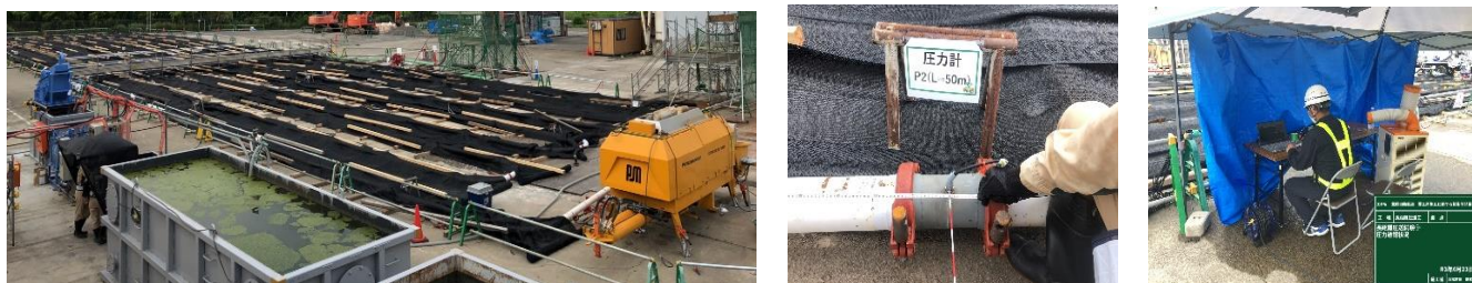
図-1 長距離圧送試験（左：配管敷設・養生状況，中：圧力計，右：配管圧力計測状況）
