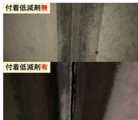
写真4 脱型後の目地部状況
