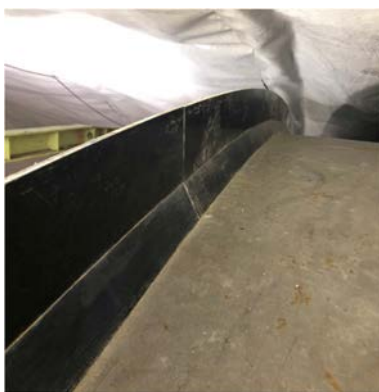
写真3 妻型枠プレート
