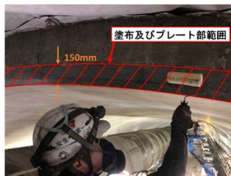
写真2 付着低減剤塗布状況
